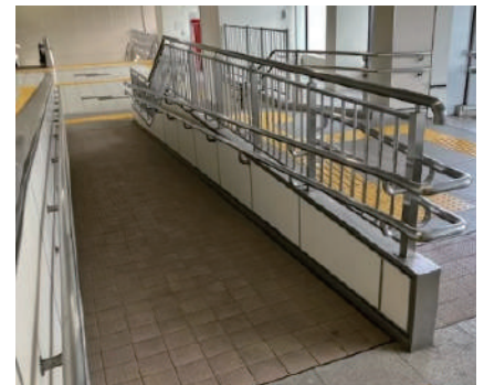
車いす用スロープ
