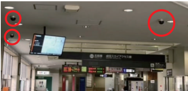
駅構内コンコースの防犯カメラの設置
