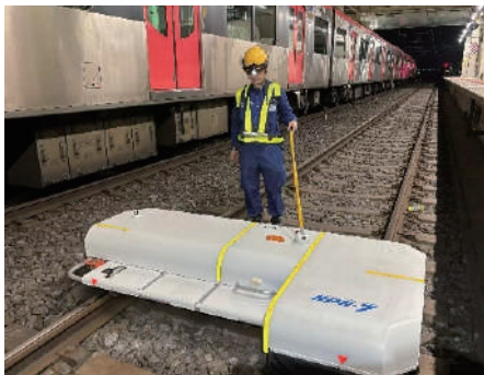
レールの測定
