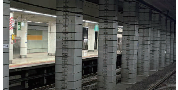
矢切駅 耐震補強された柱
