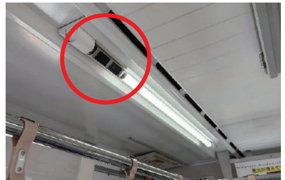
列車内の防犯カメラの設置
