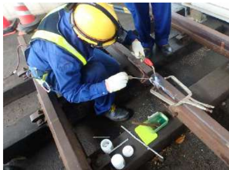
レールボンドの取付け（電気区）
