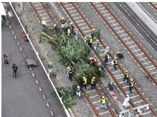
軌道を支障した倒木の撤去作業
