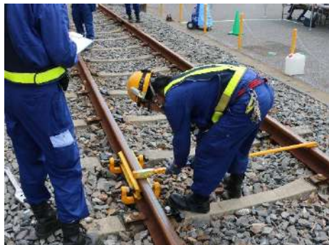
レールの測定
