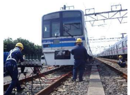
車両の脱線復旧（車両区）
