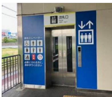
車いす対応のエレベーター
