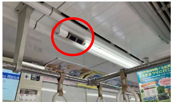
列車内の防犯カメラの設置
