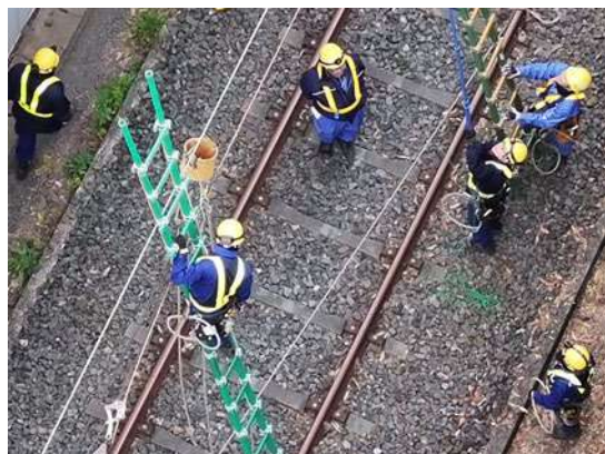
断線した電車線の復旧作業
