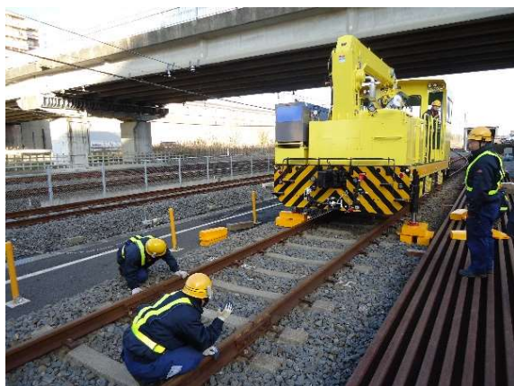
保守作業車の脱線復旧訓練（施設）
