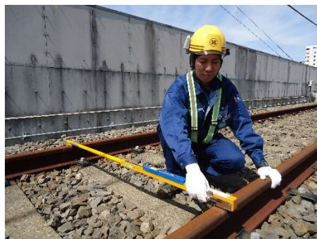
レールの測定
