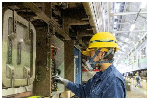
床下機器類の点検
