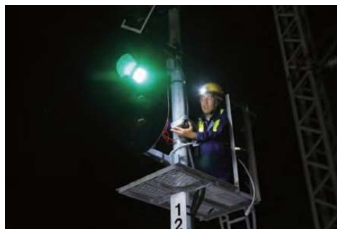
信号機の点検
