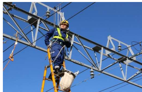
電車線の点検
