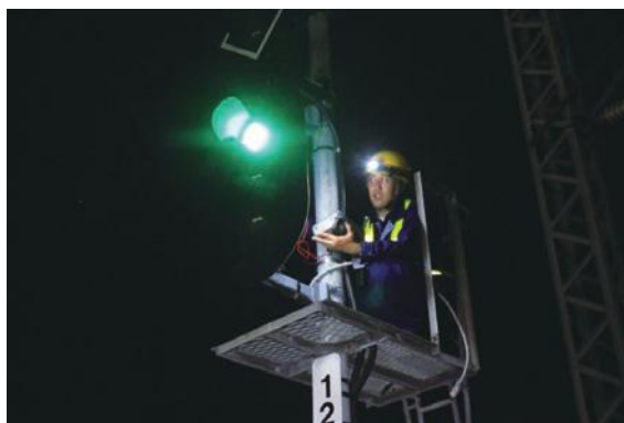
信号機の点検
