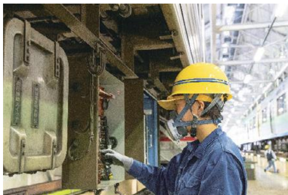
床下機器類の点検
