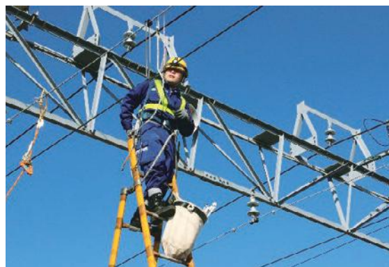
電車線の点検
