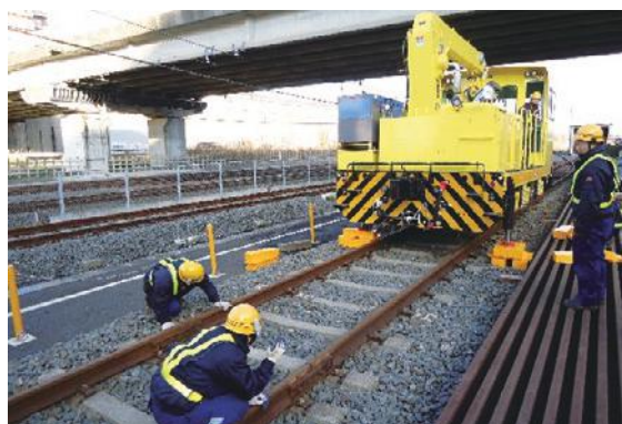
保守用重機の脱線復旧訓練
