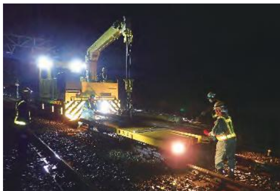
レール交換作業
