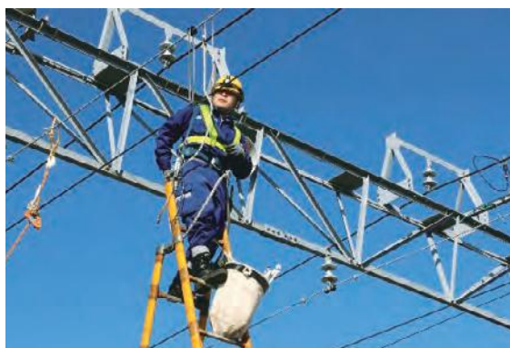
電車線の点検
