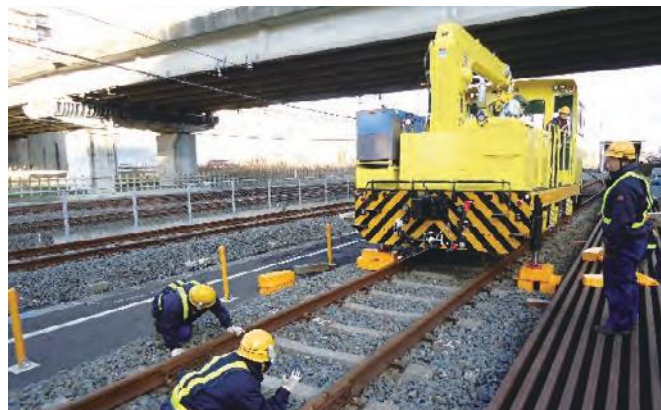
保守用重機の脱線復旧訓練
