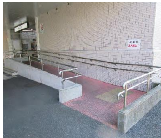
車いす用スロープ
