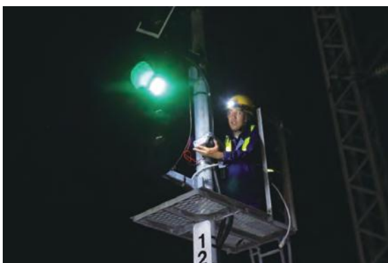
信号機の点検
