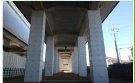
大町～新鎌ヶ谷間高架橋
