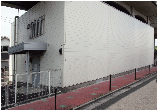
レンタル納戸外観
