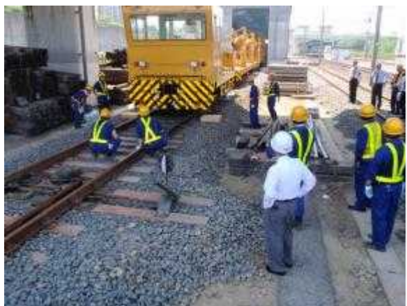
モーターカー脱線復旧訓練
