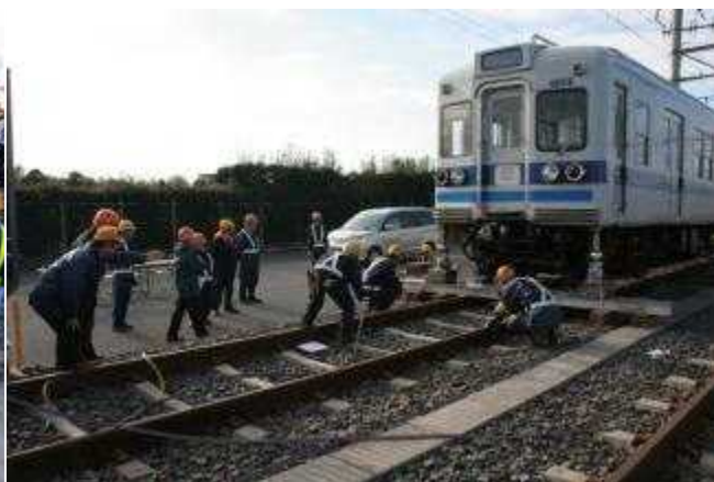
列車脱線復旧訓練
