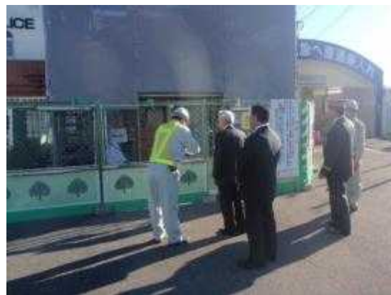
矢切駅エレベータ新設工事視察
