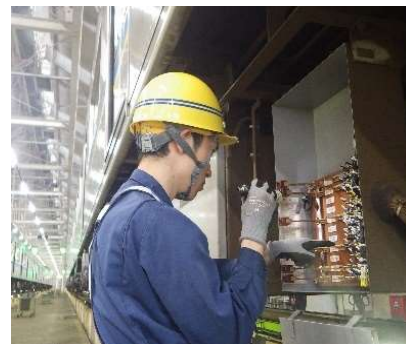
車両床下機器類の点検
