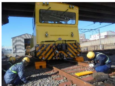
保守作業車の脱線復旧訓練（施設区）
