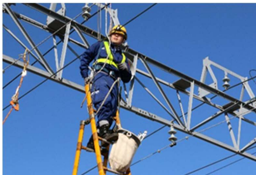
電車線の点検
