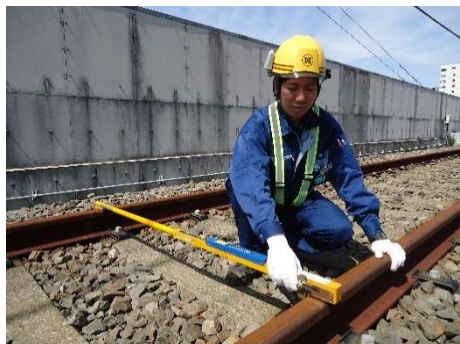
レールの測定
