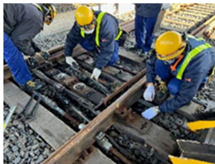
転てつ装置交換訓練（電気区）
