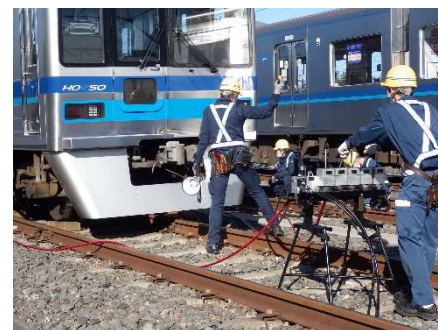
脱線復旧訓練（車両区）
